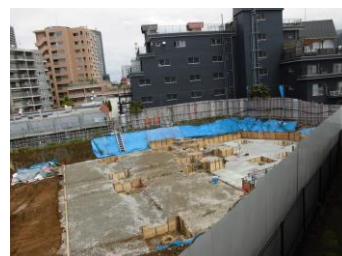
新園舎の基礎ができあがってきました
