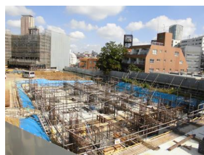
新園舎建設も着々と進行中。
