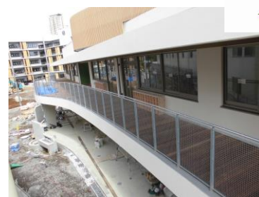
工事中的新園舎。テラスはウッドデッキ調。靴箱も設置されました。完成間近!
