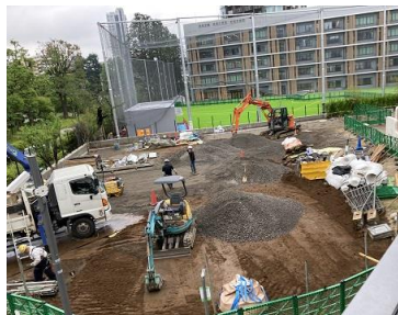
園庭工事も最終段階! いろいろな車での作業がよく見えます。
